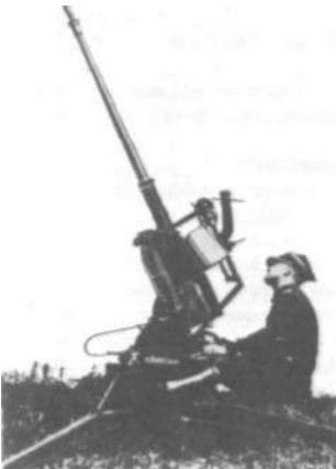
Rys. 20.2. Najcięższy karabin maszynowy model A z magazynkiem bębnowym
