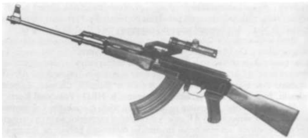
Rys. 15.3. Karabinek AK z lunetą PU; wersja z 1958 r.
