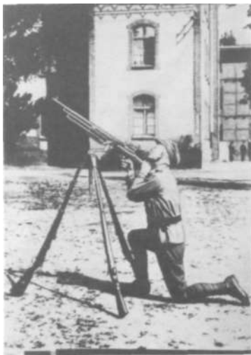
Rys. 18.7. Podstawa do ręcznego karabinu maszynowego. Laweta (typ 1)
